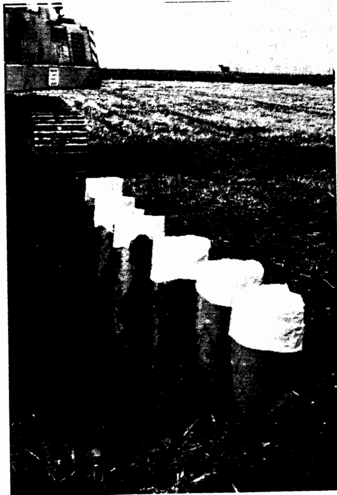
Abb. 3.2.2 Ausgraben der Säulen
